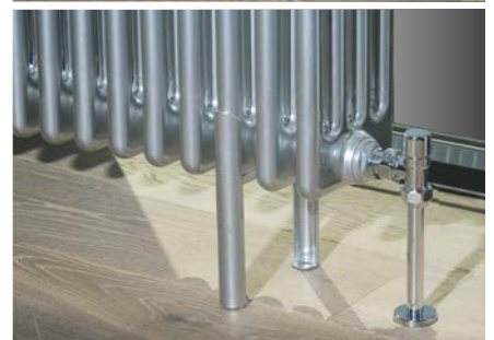
Montage van DRL leidingcovers om MULTICOLOM radiator.
